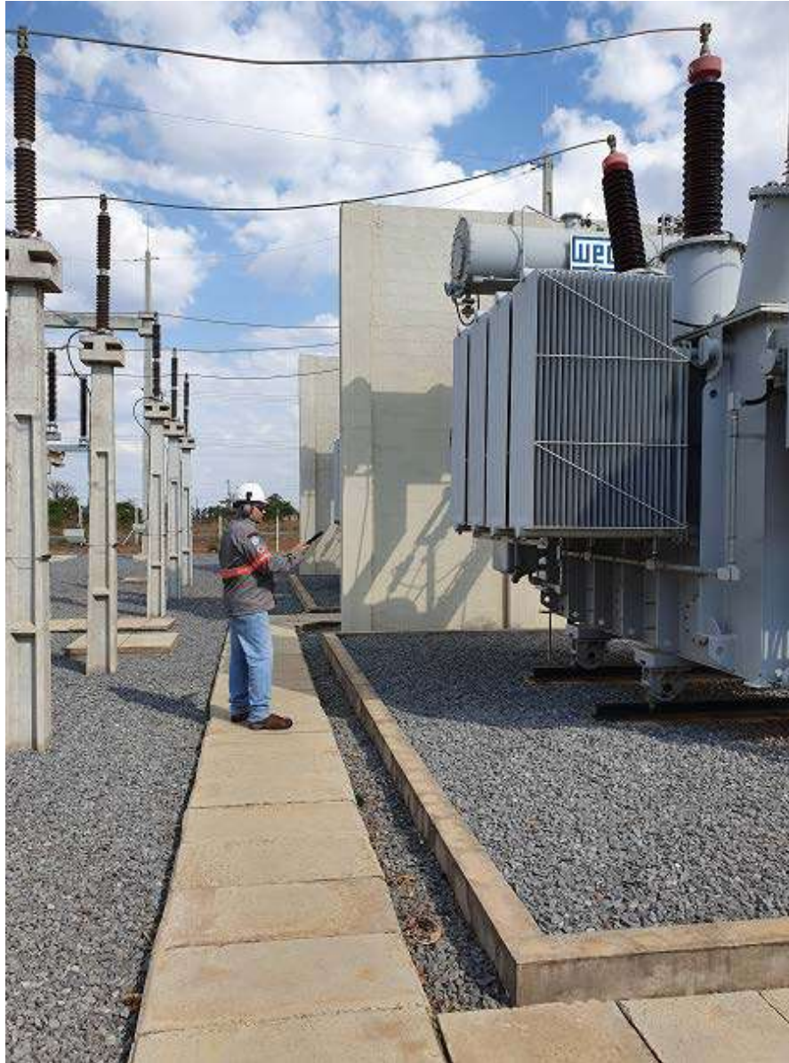
Figura 11 - Demonstrativo de medições realizadas em campo
