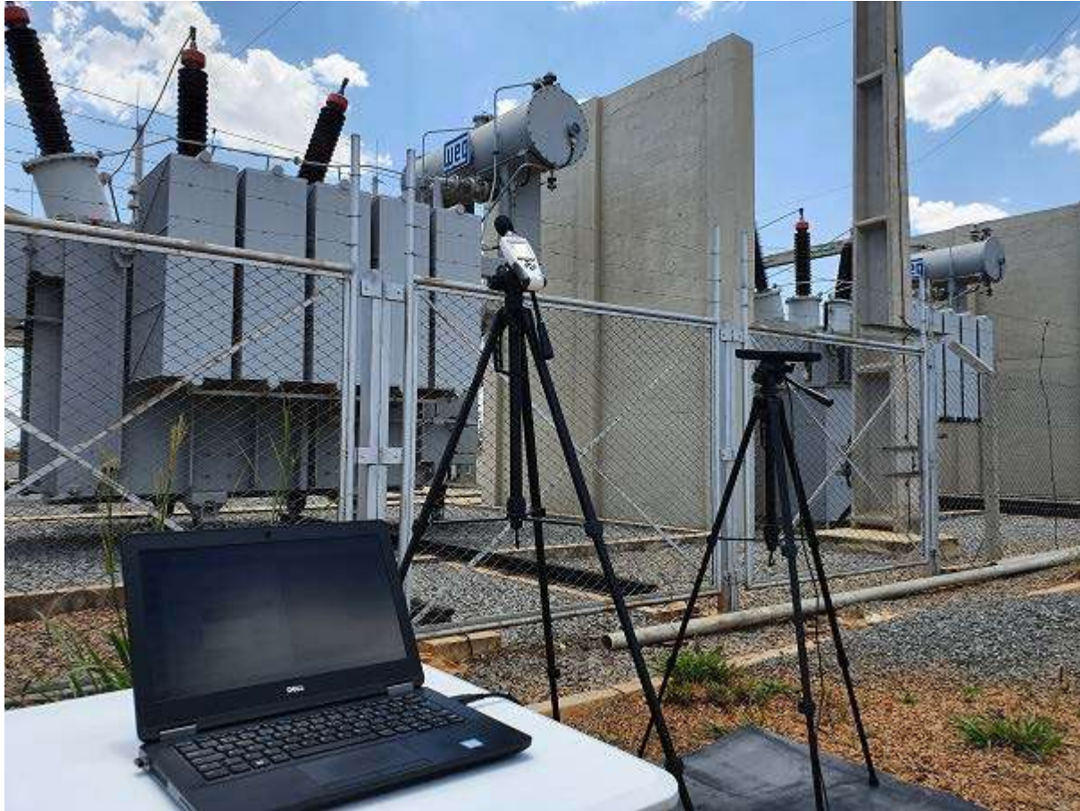
Figura 2 – Demonstrativo de medições realizadas em campo
