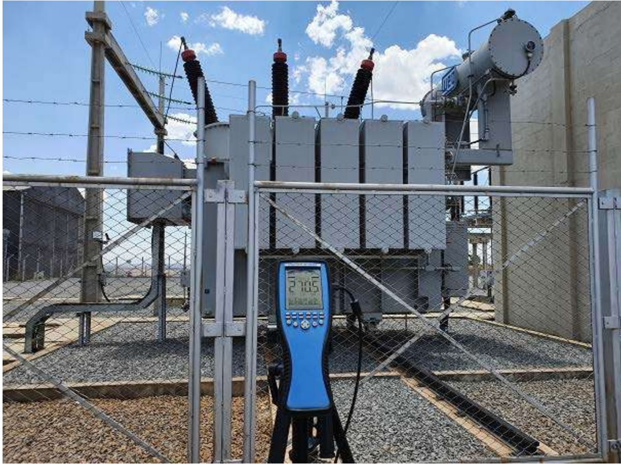
Figura 3 - Demonstrativo de medições realizadas em campo
