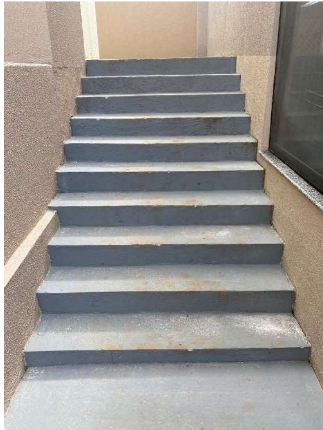
Imagem 04 – Escada Bloco Z
