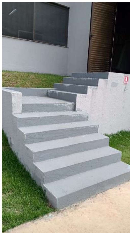
Imagens 03 e 04 – Escada Lavanderia
