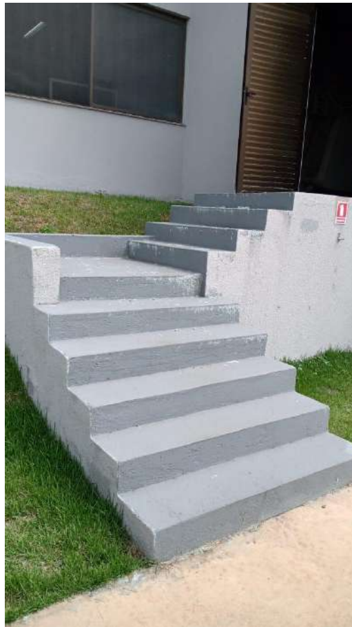
Imagens 03 e 04 – Escada Lavanderia
