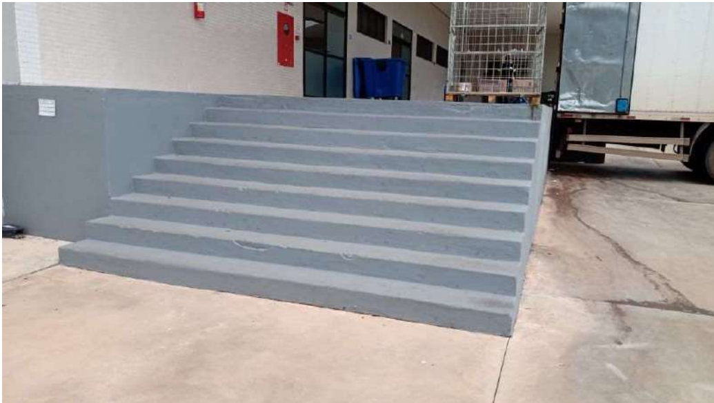
Imagens 09 e 10 – Escada Docas
