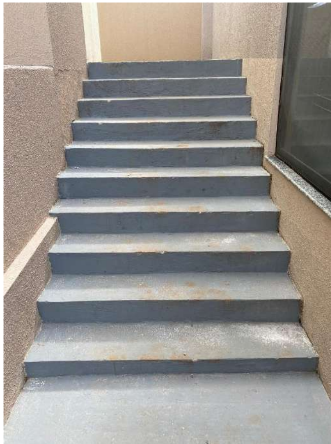
Imagem 04 – Escada Bloco Z
