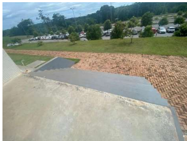
Imagens 01 e 02 – Escada Alcoxarifado
